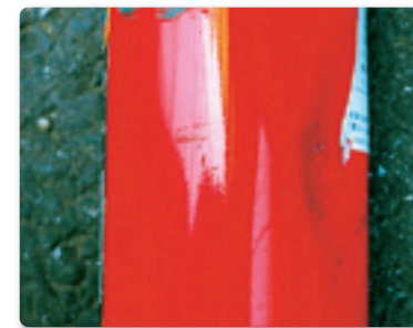
使用に耐えない変形
