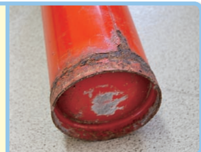
溶接部とその周辺の腐食
